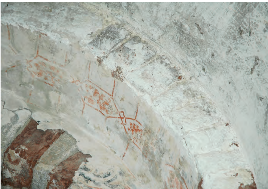
Restos de policromía en el intradós del arco de ingreso al absidiolo sur
