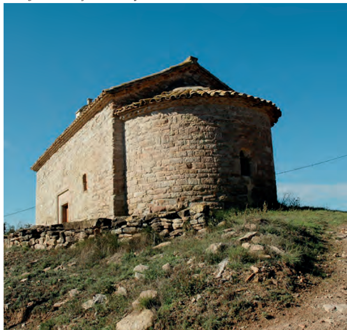
Vista general de la fachada sur y el ábside
