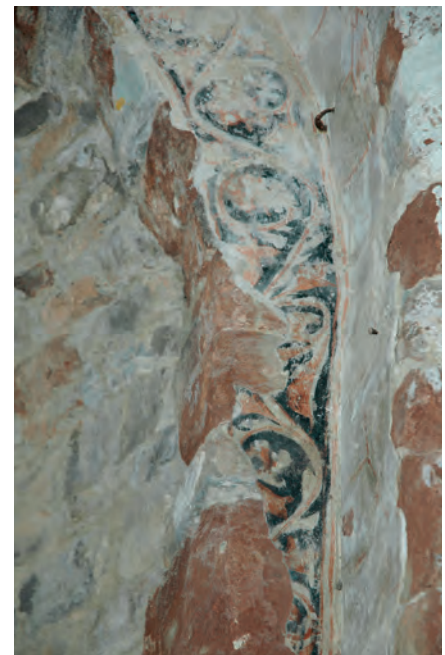
Policromía del arco de ingreso al absidiolo sur
