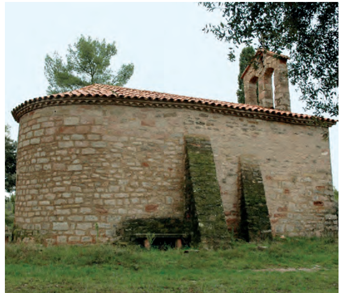
Vista general. Fachada norte
