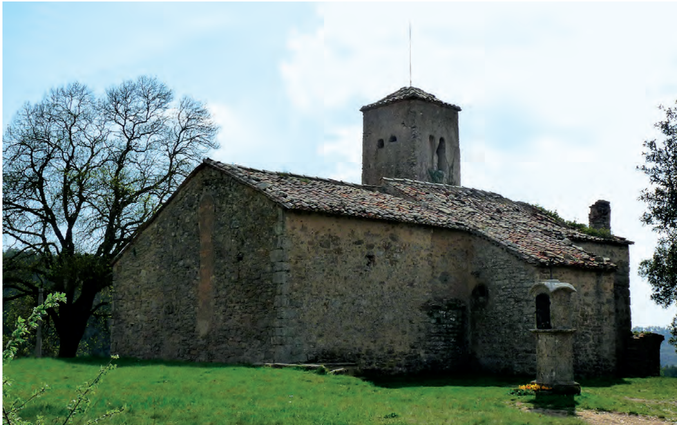
Vista general de la fachada norte
