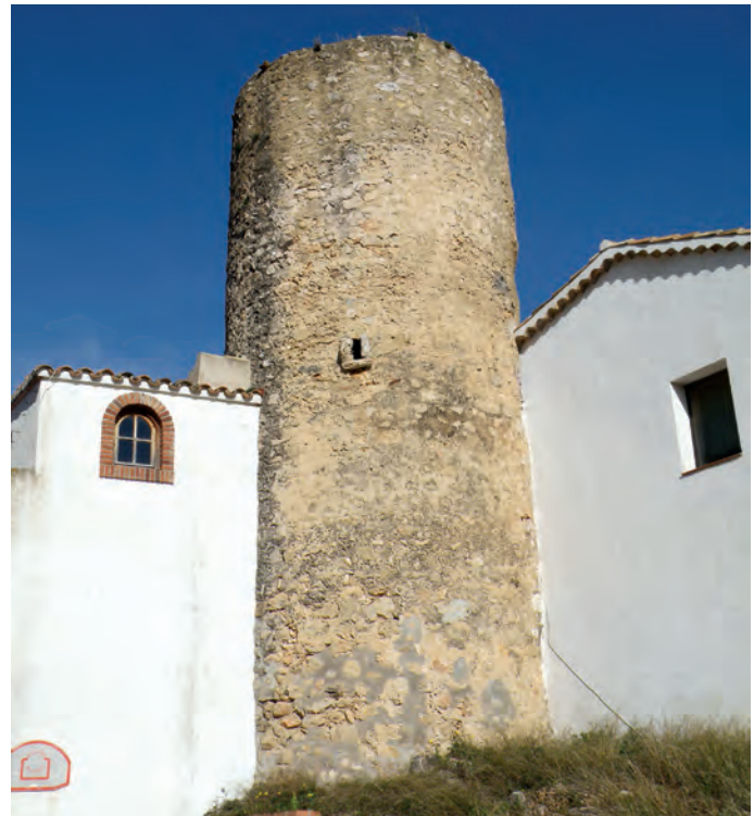
Vista general de la Torreta de Castellví junto a la masía
