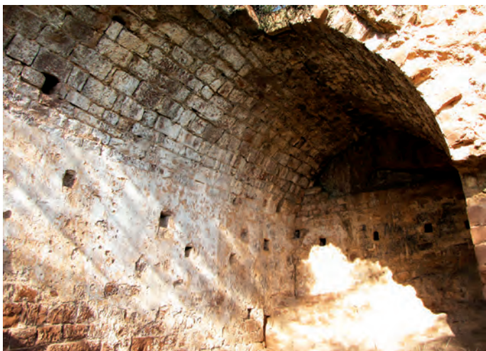
Cámara del recinto inferior
