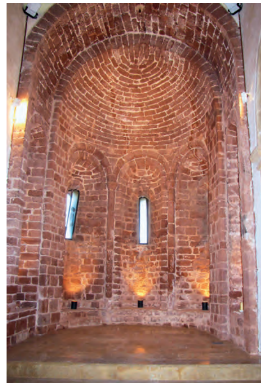
Interior del ábside
