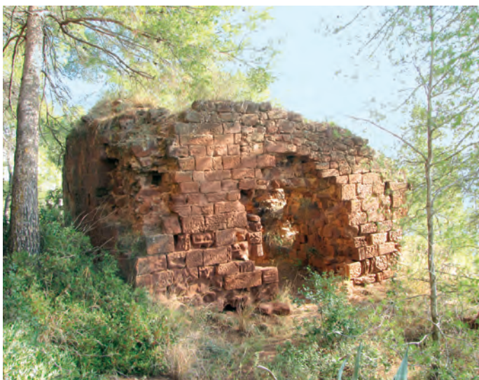
Exterior de la capilla
