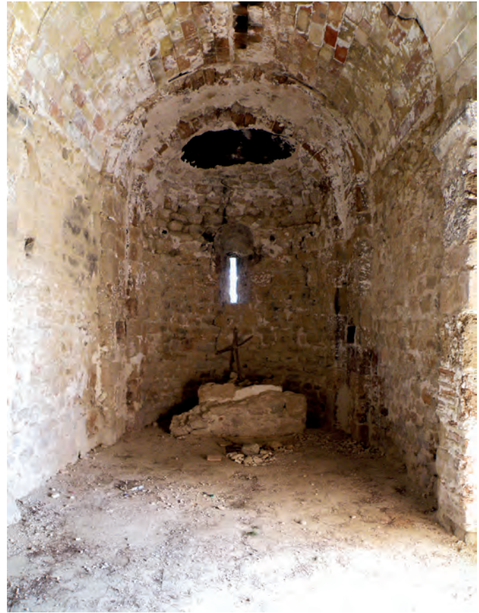
Interior hacia el ábside
