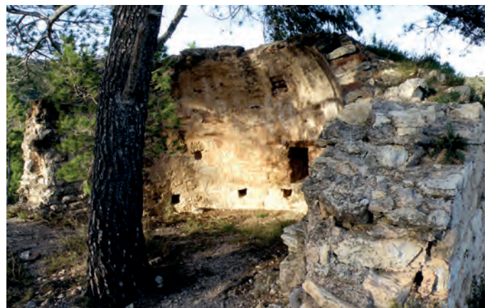
Restos del ábside
