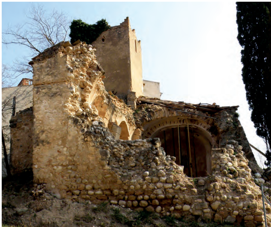
Vista general de la fachada occidental
