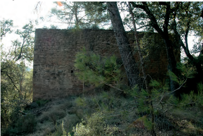
Vista general de los restos de la iglesia
