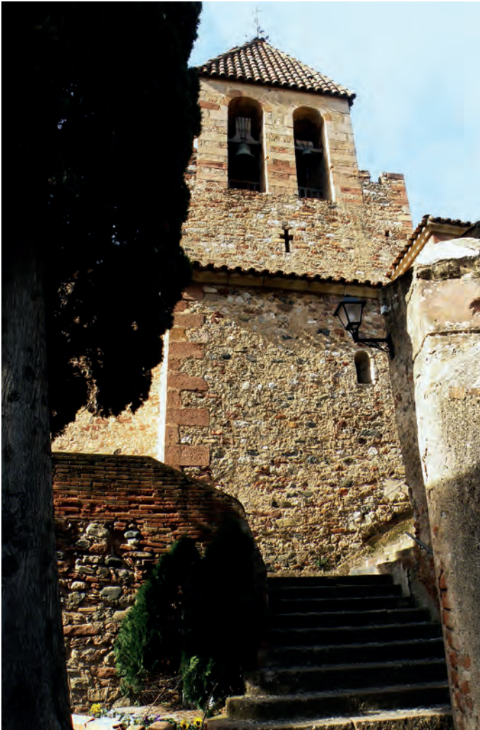
Vista general y fachada occidental
