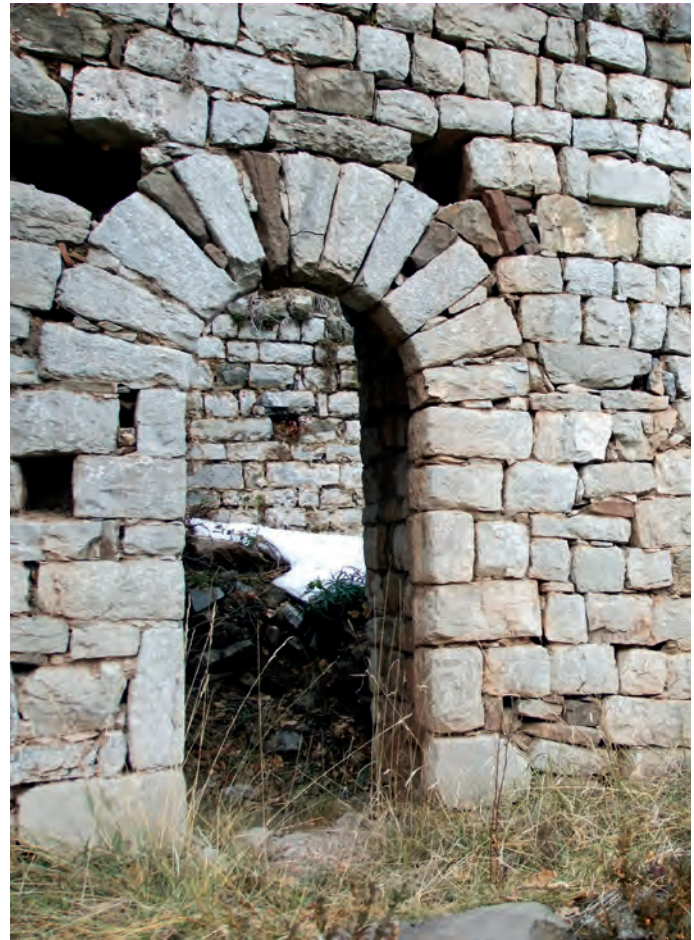
Portada en el muro sur
