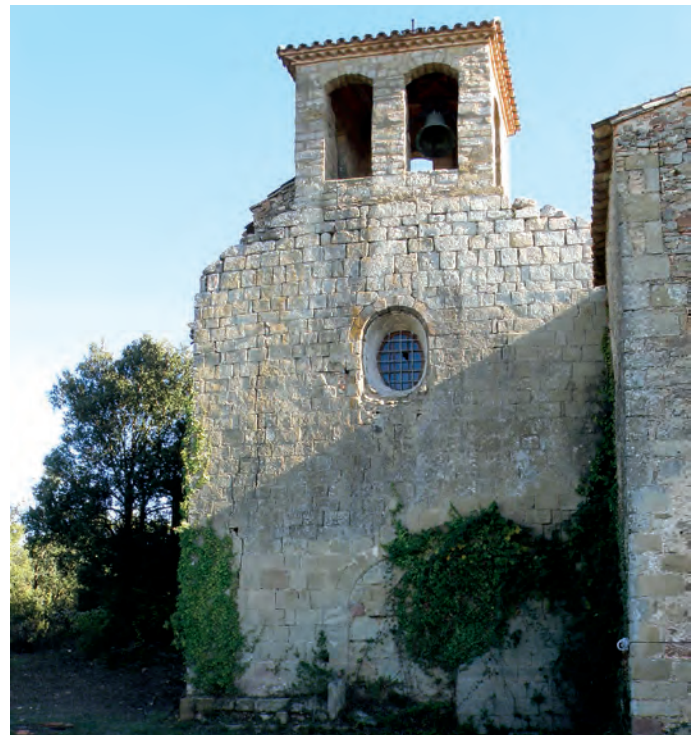
Portada occidental cegada
