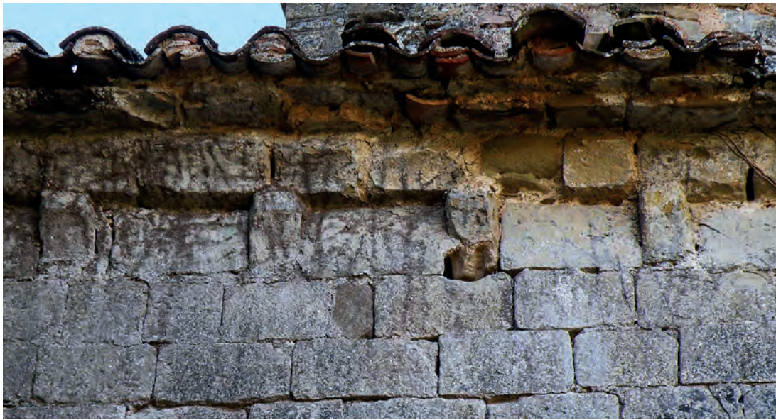
Canecillos que sostienen la cornisa del muro septentrional
