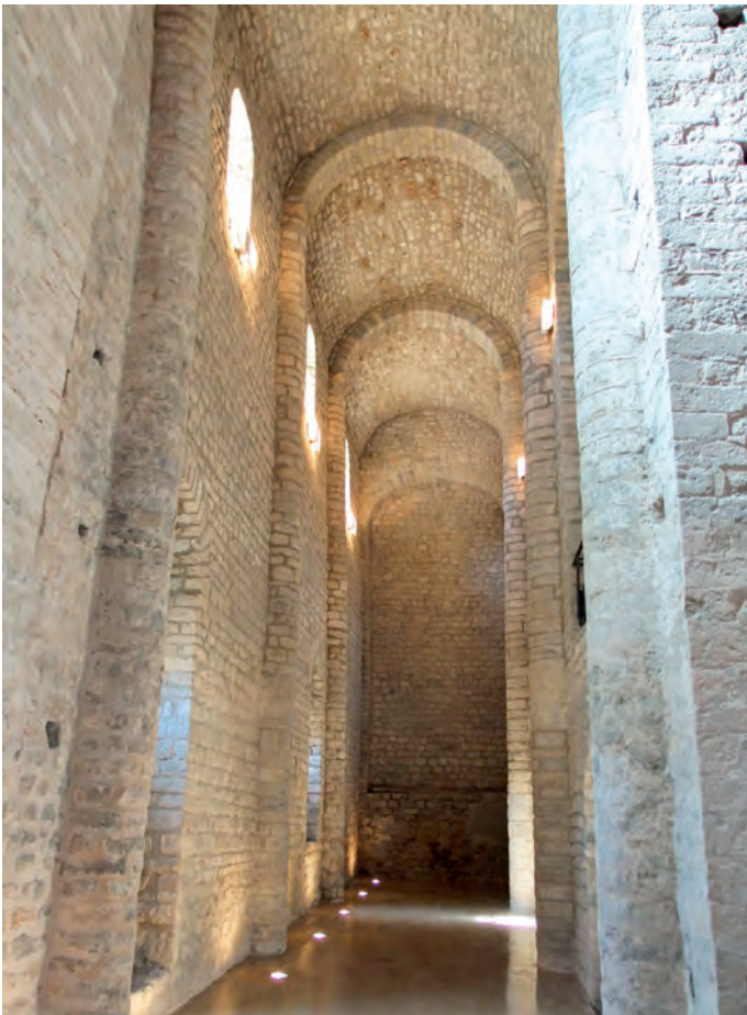
Interior de la nave sur
