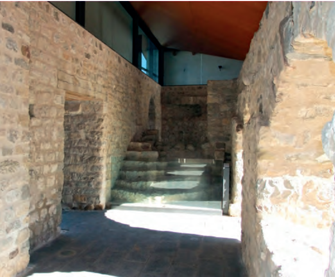
Galería norte del claustro
