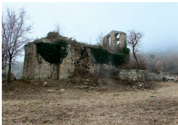
Vista general del ábside y fachada norte
