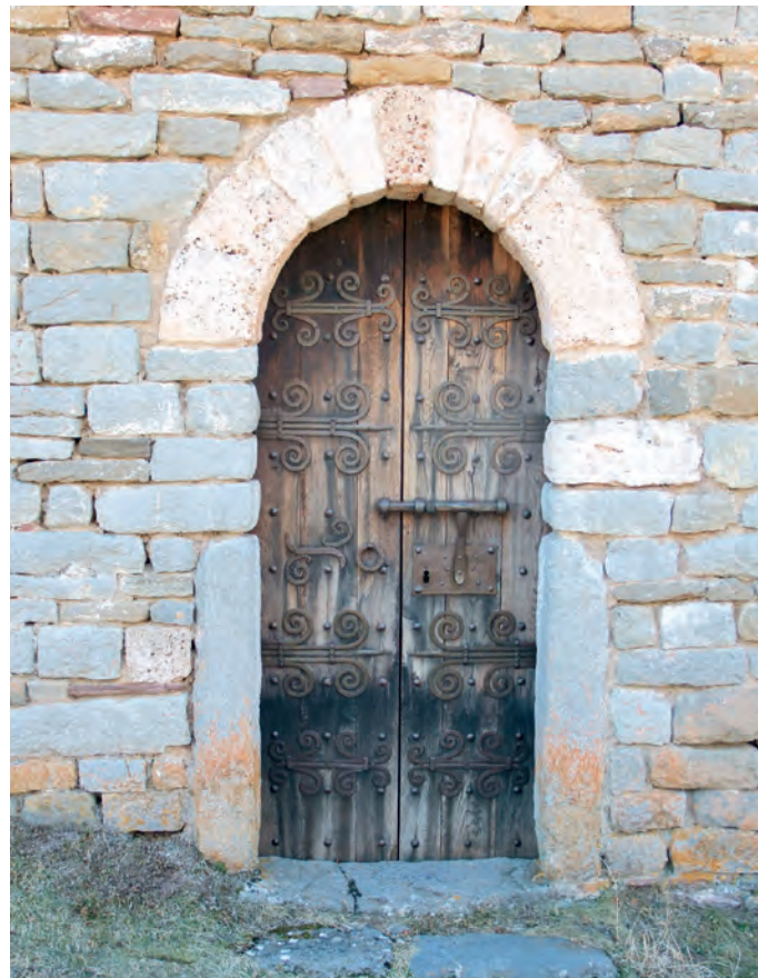
Portada en la fachada norte
