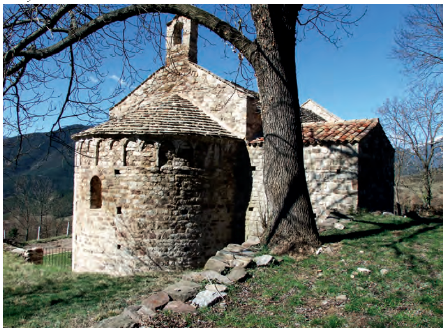
Vista general de la cabecera
