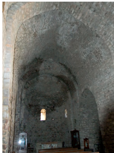
Interior de la nave
