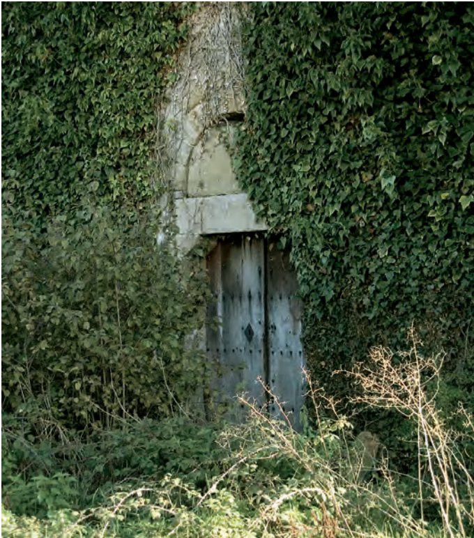
Puerta de acceso en el muro septentrional
