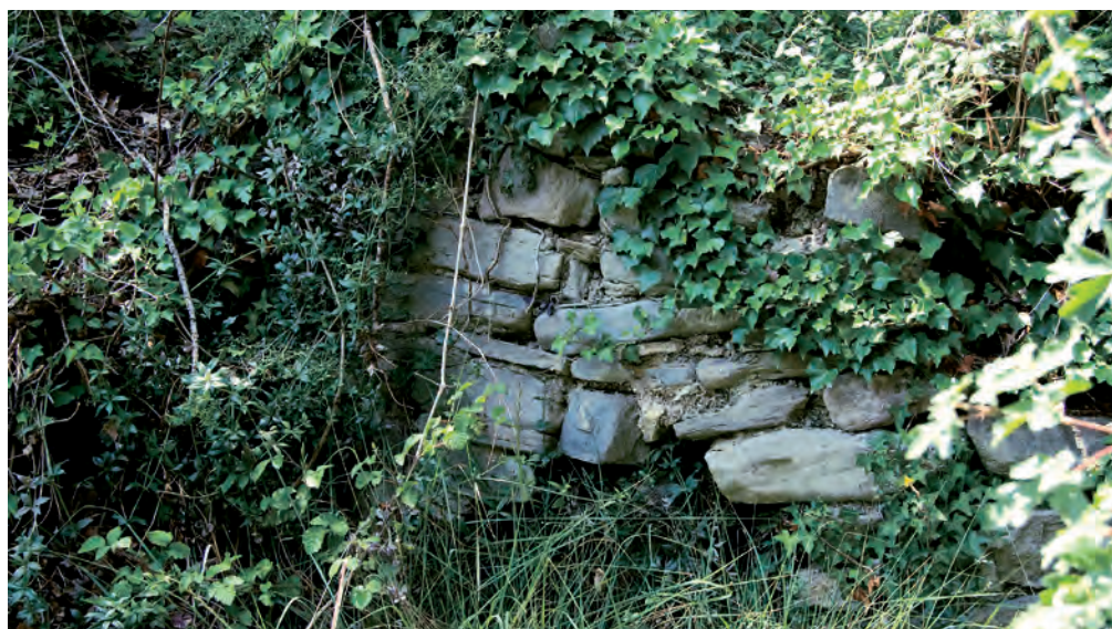
Restos de muro
