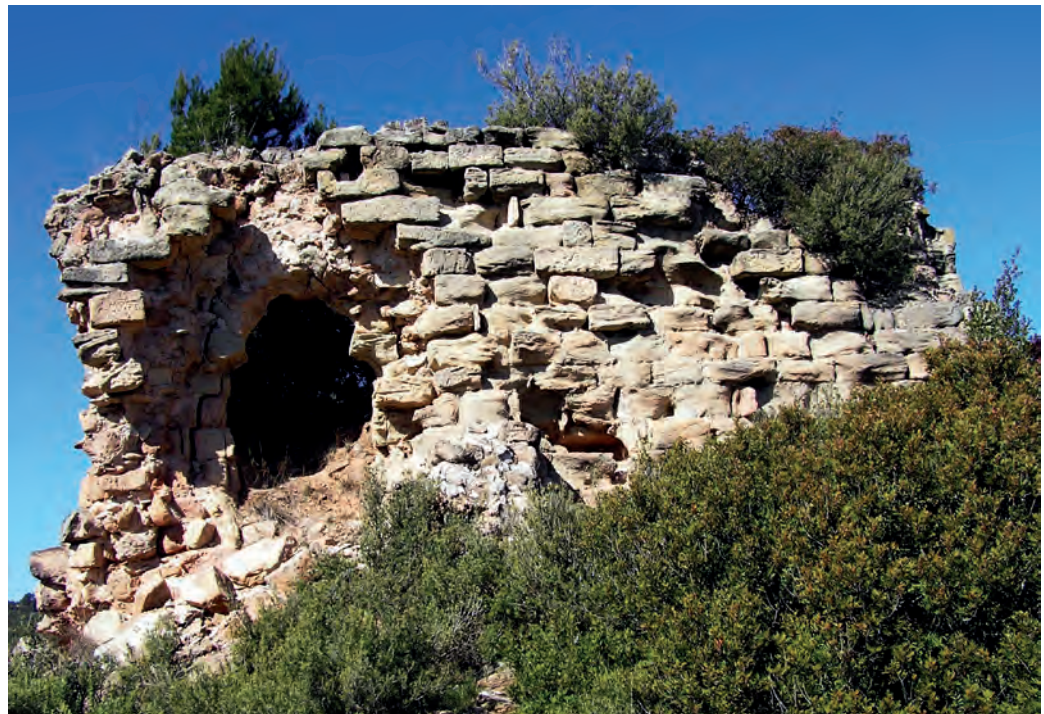
Restos de la torre
