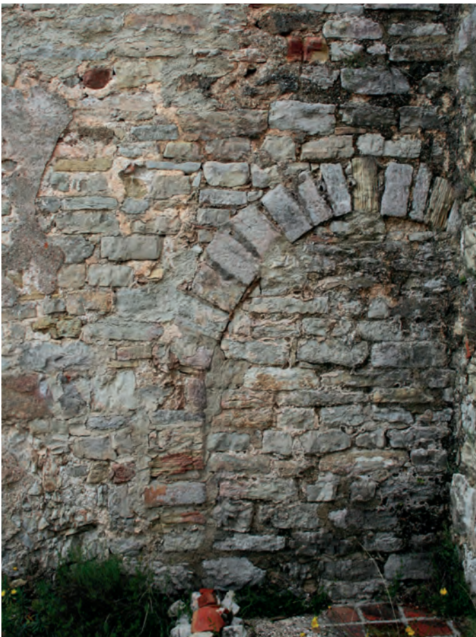
Detalle del muro norte
