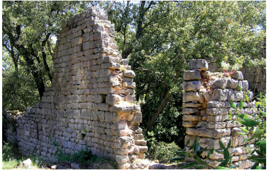
Muro norte de la nave oriental
