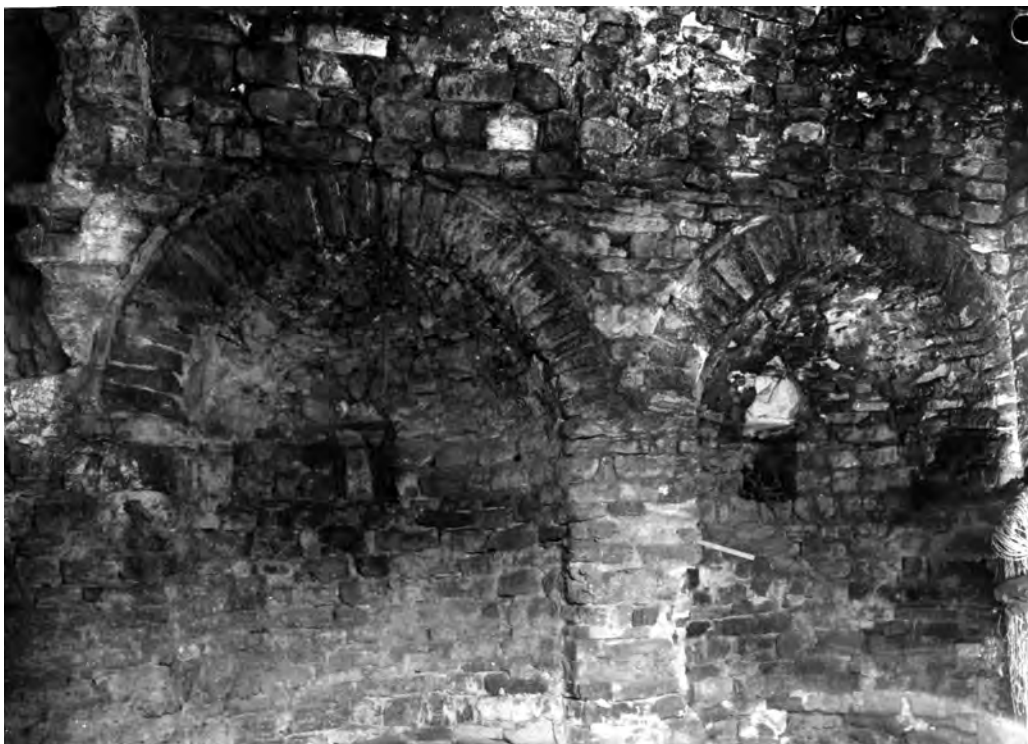
Absidiolos en 1960. ©Servei de Patrimoni Arquitectònic Local. Diputació de Barcelona
