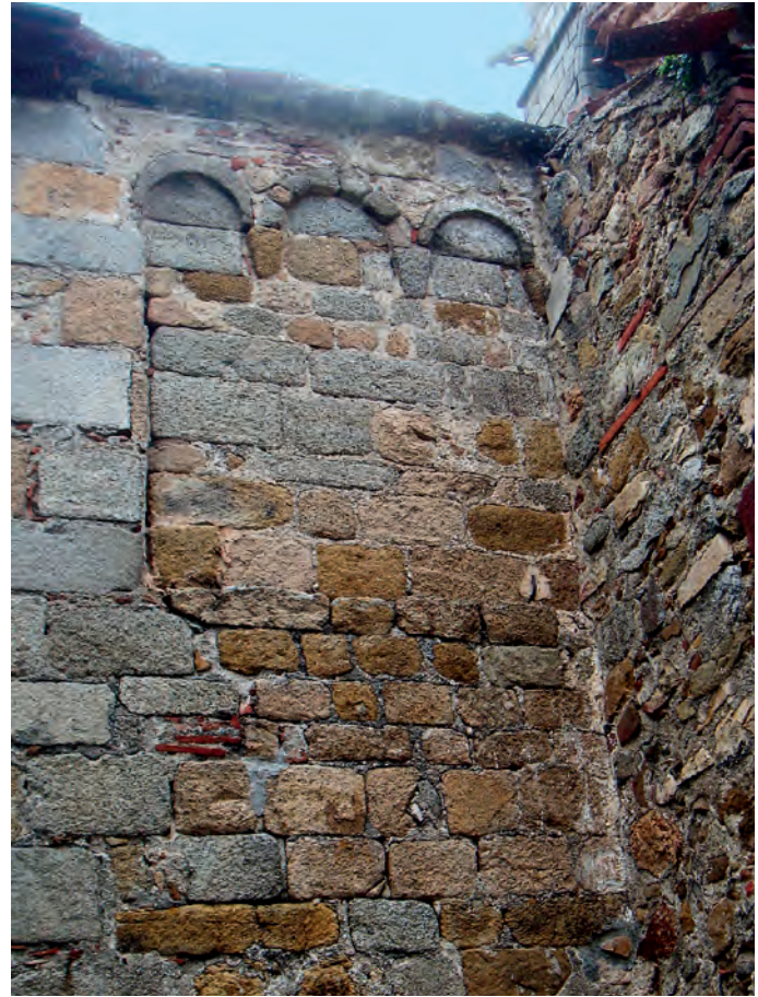
Arquillos del muro sur
