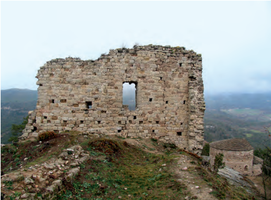
Restos del muro norte con la Capilla de Sant Vicenç al fondo
