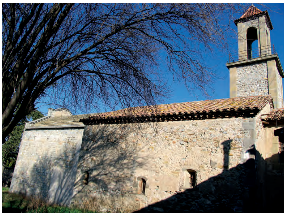
Vista general de la fachada sur
