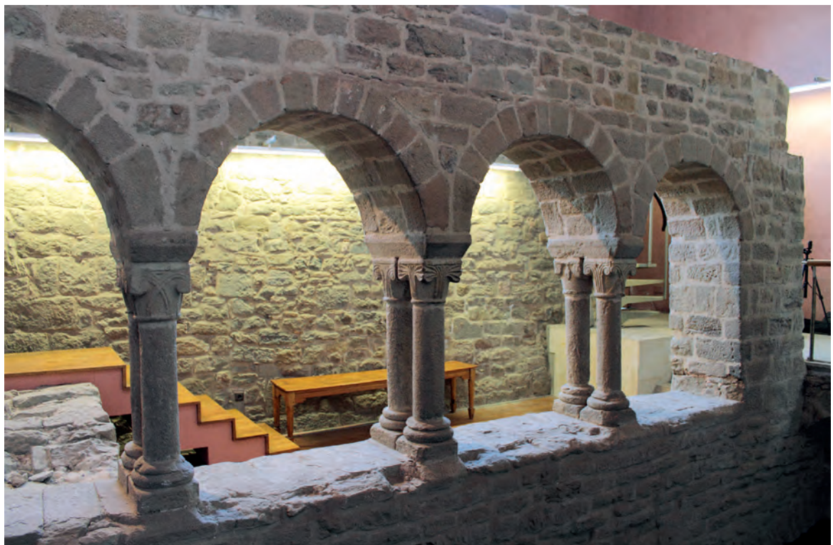
Restos del claustro
