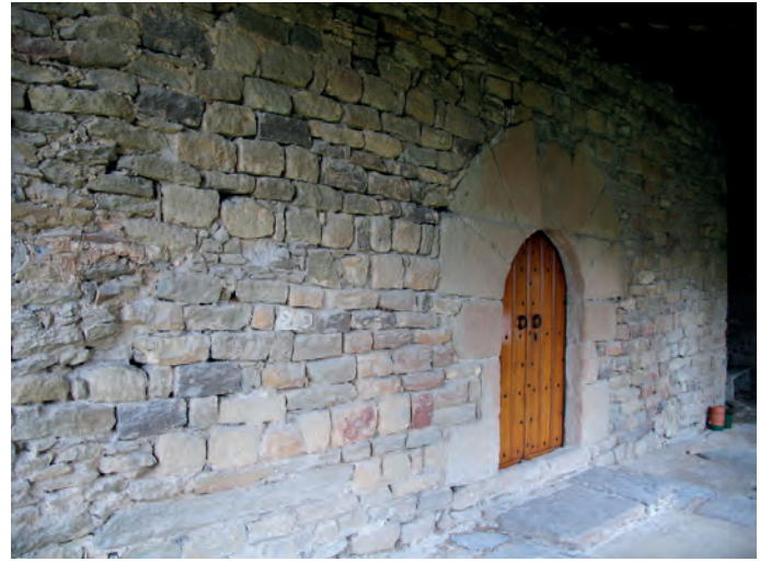
Detalle del muro meridional
