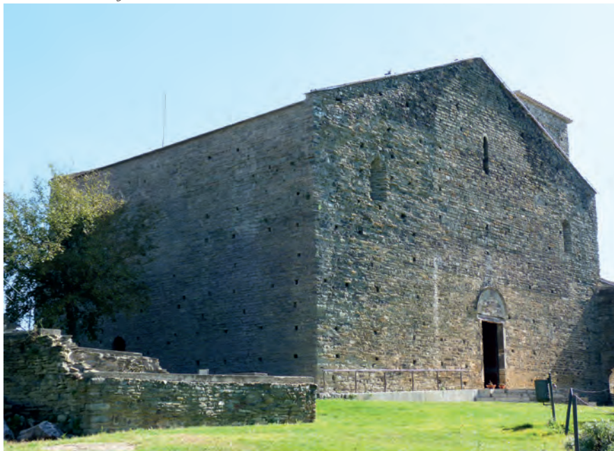
Vista exterior de la iglesia desde el lado noroeste
