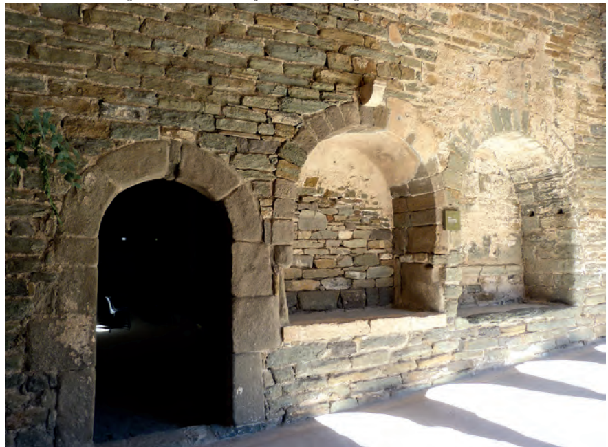
Puerta de acceso a la iglesia desde el claustro y arcosolios en la galería norte
