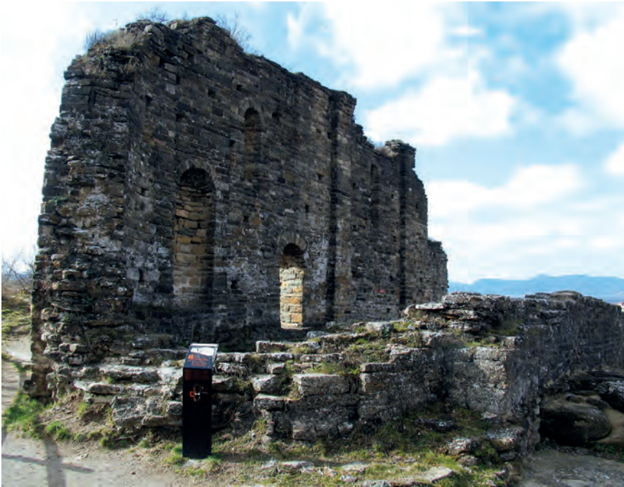
Vista general de los restos de la cabecera
