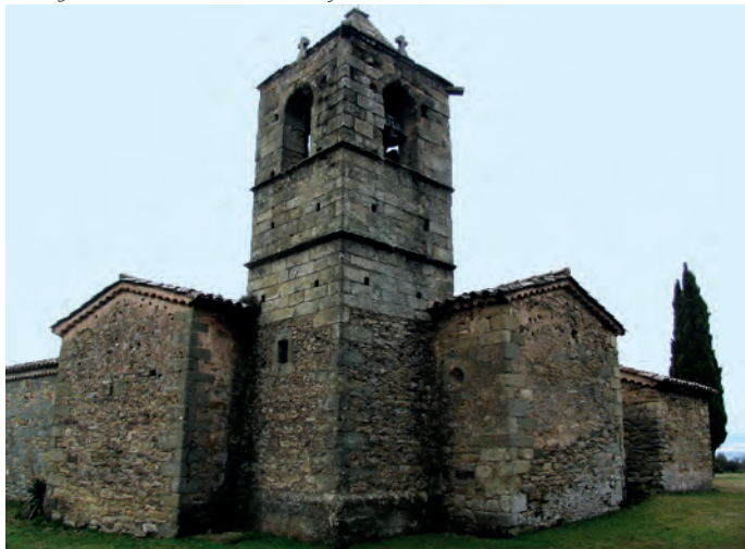
Vista general del estado actual del edificio
