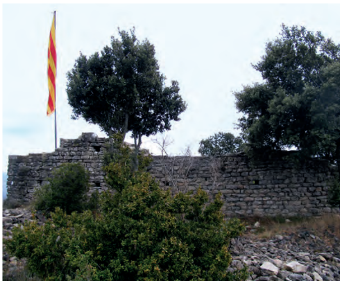
Restos de muro del recinto
