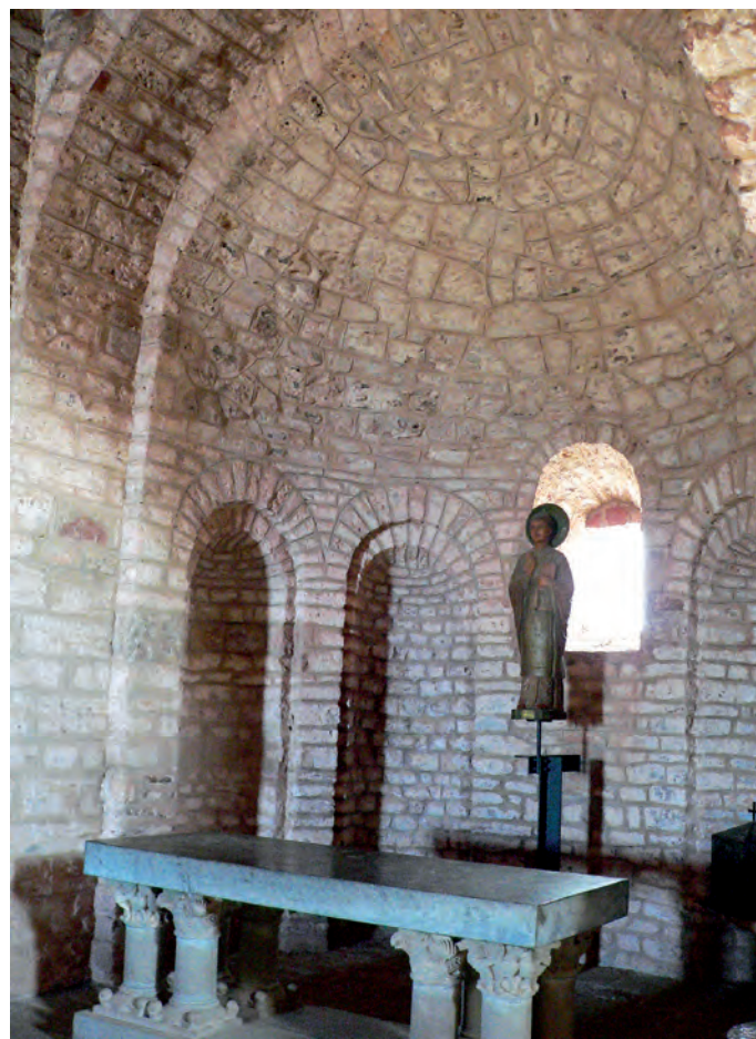
Detalle del ábside y nichos absidales
