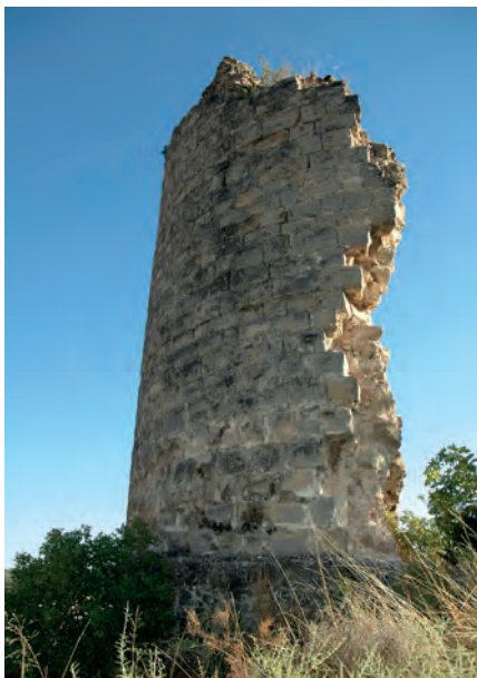
Ruínas de la torre desde el Oeste
