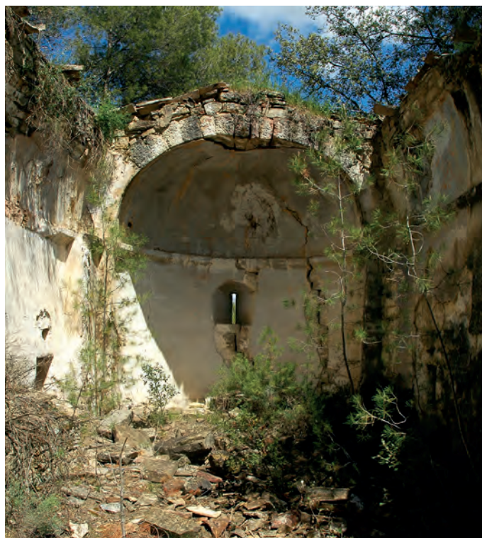
Vista del interior de la nave y la cabecera
