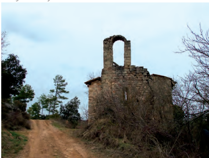
Vista general de la fachada occidental
