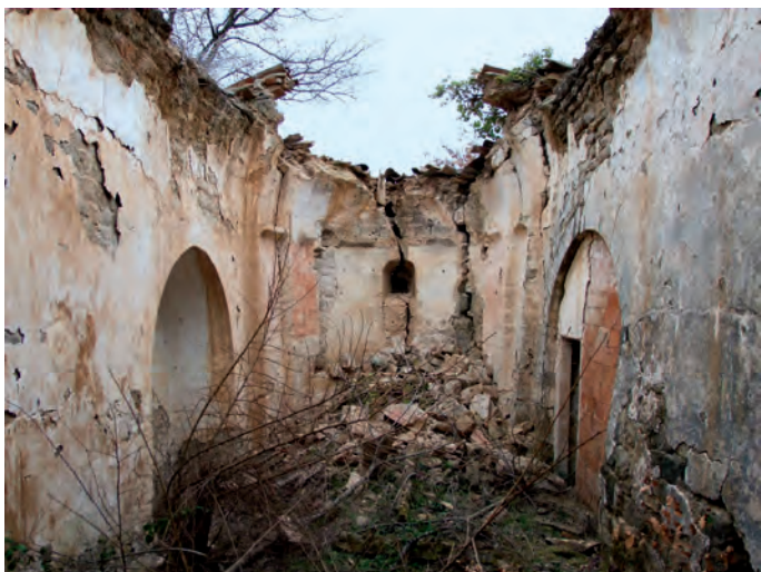
Estado actual del interior
