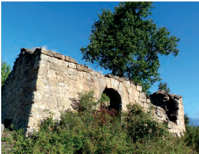
Vista general de la fachada sur
