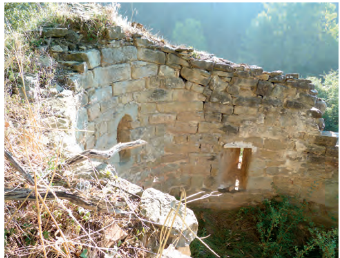
Interior del ábside
