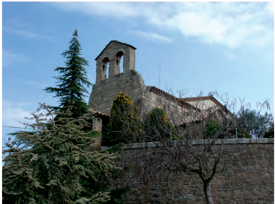
Vista general del actual edificio
