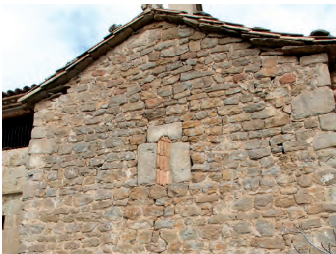
Muro del extremo sur del transepto
