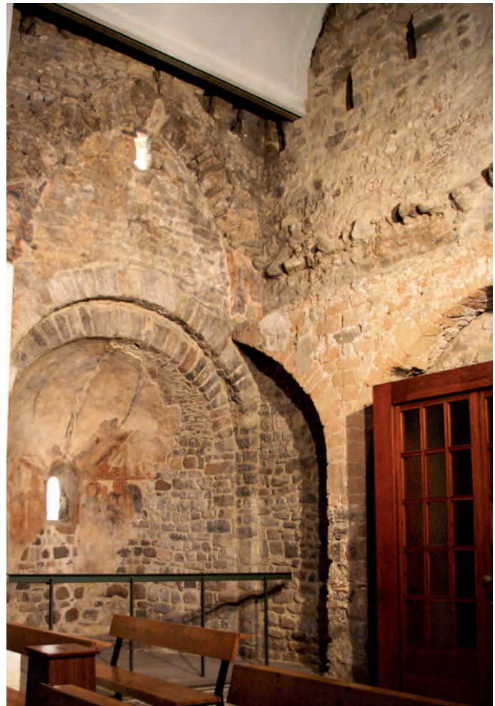
Situación del antiguo ábside
