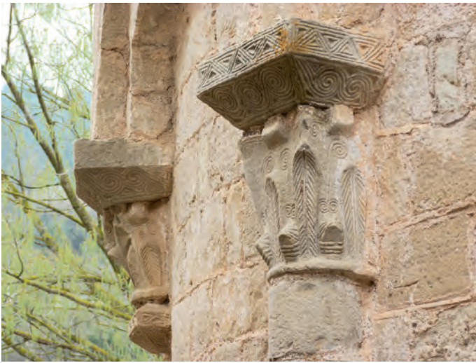
Capiteles del exterior del ábside principal
