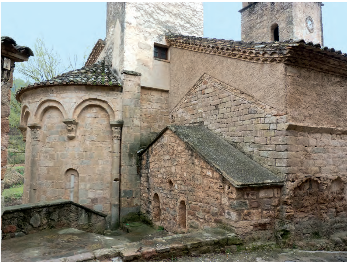
Vista exterior de los dos ábsides
