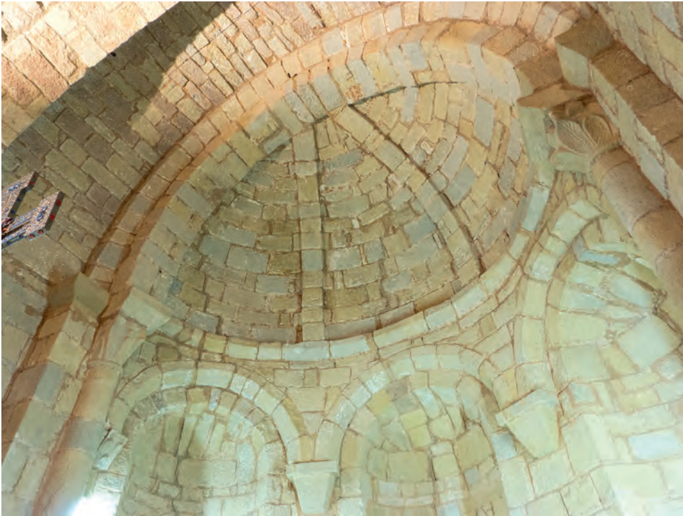
Vista del ábside principal
