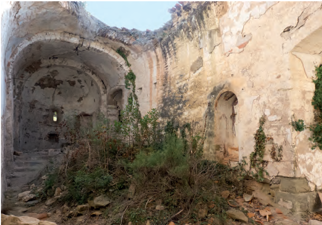
Vista interior de la nave y el ábside
