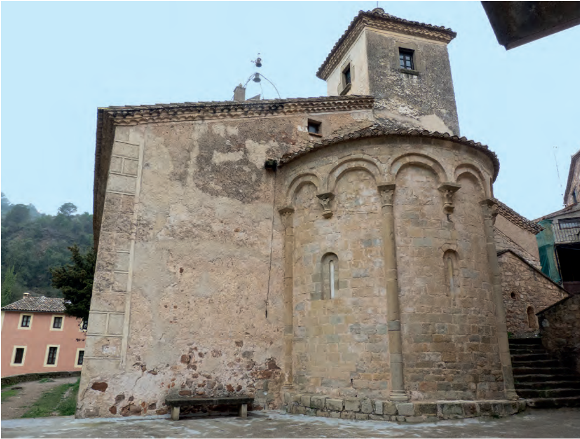
Vista general exterior desde el Sureste
