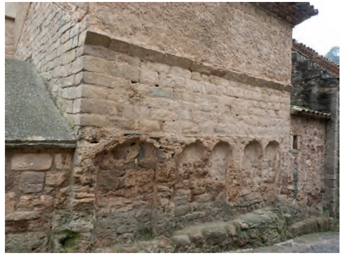
Vista exterior del muro norte
