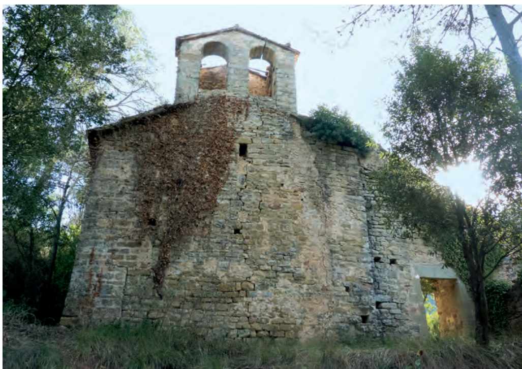
Vista exterior de la fachada oeste
