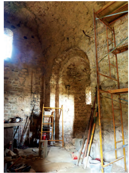
Vista interior del absidiolo norte
