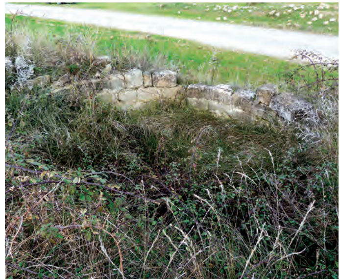
Vista de los restos del ábside
