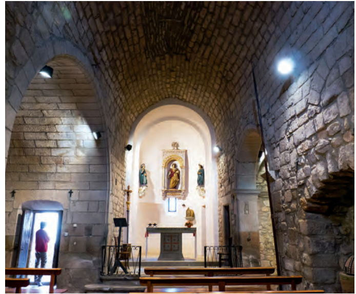
Vista general del interior de la iglesia
