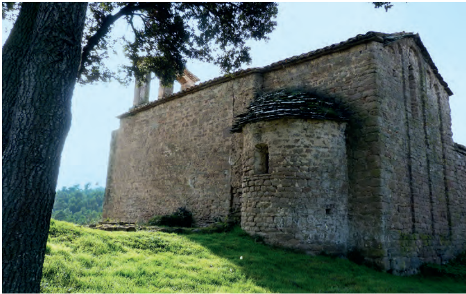
Vista exterior del absidiolo y del brazo norte del transepto
