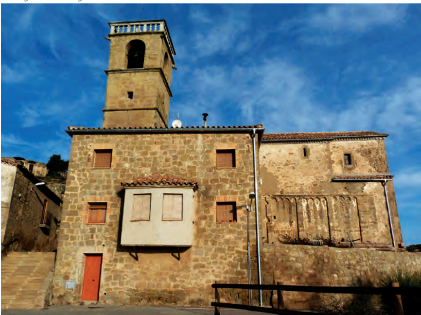
Vista general de la iglesia
