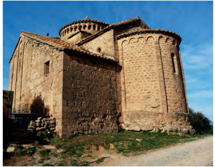
Vista general del exterior desde el Sureste
