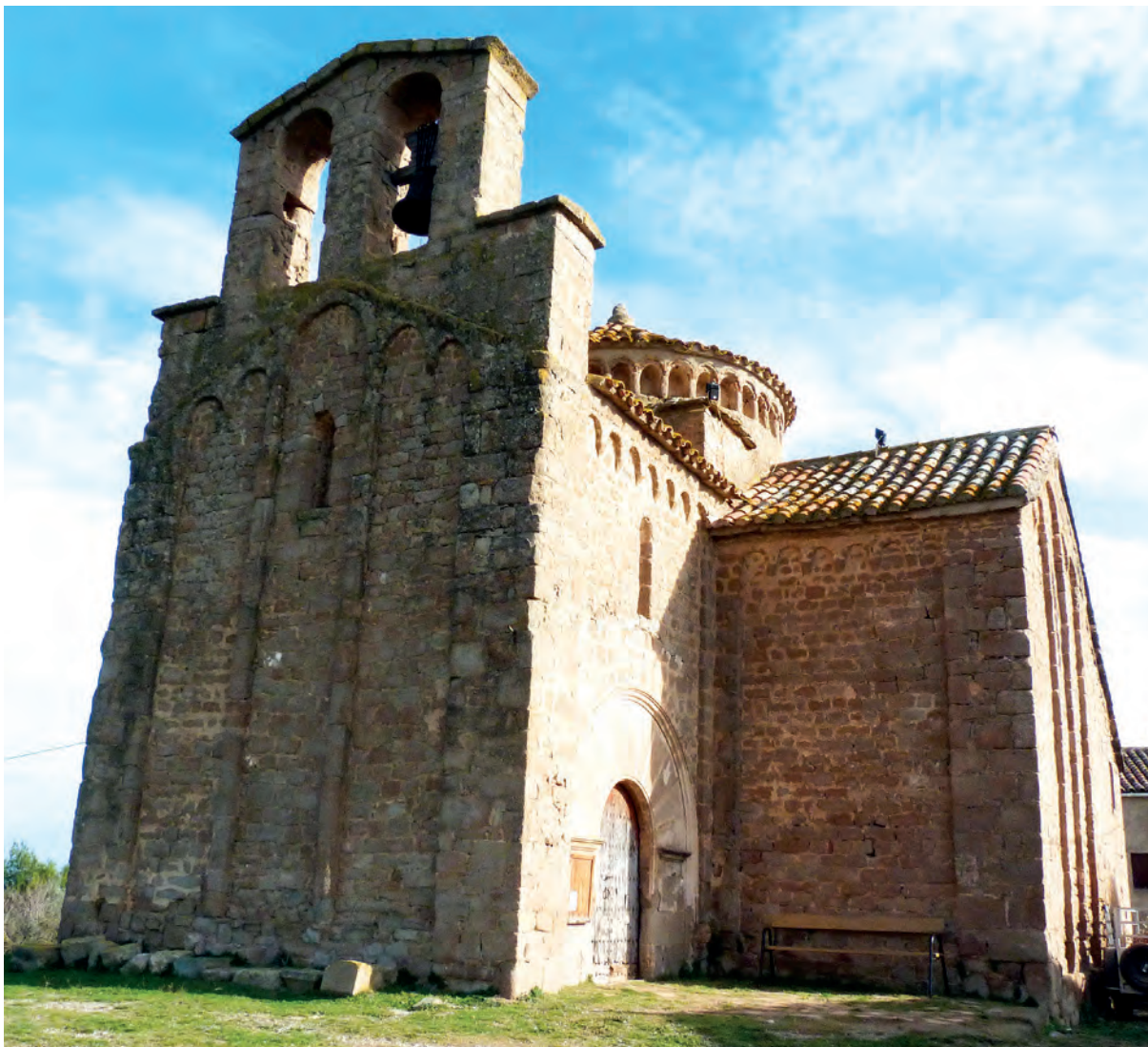
Vista general del exterior desde el Suroeste
