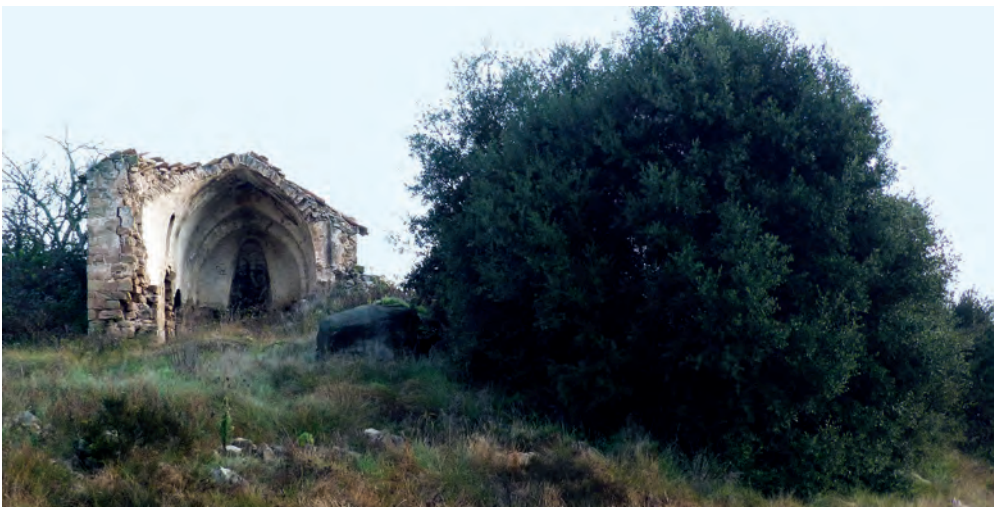
Vista general de la iglesia
