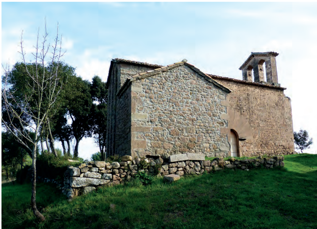
Vista general de la iglesia
