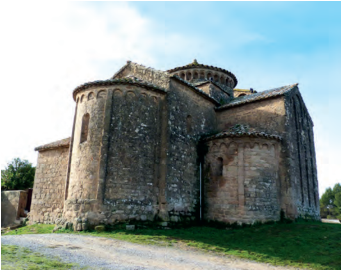
Vista general del exterior desde el Noreste
