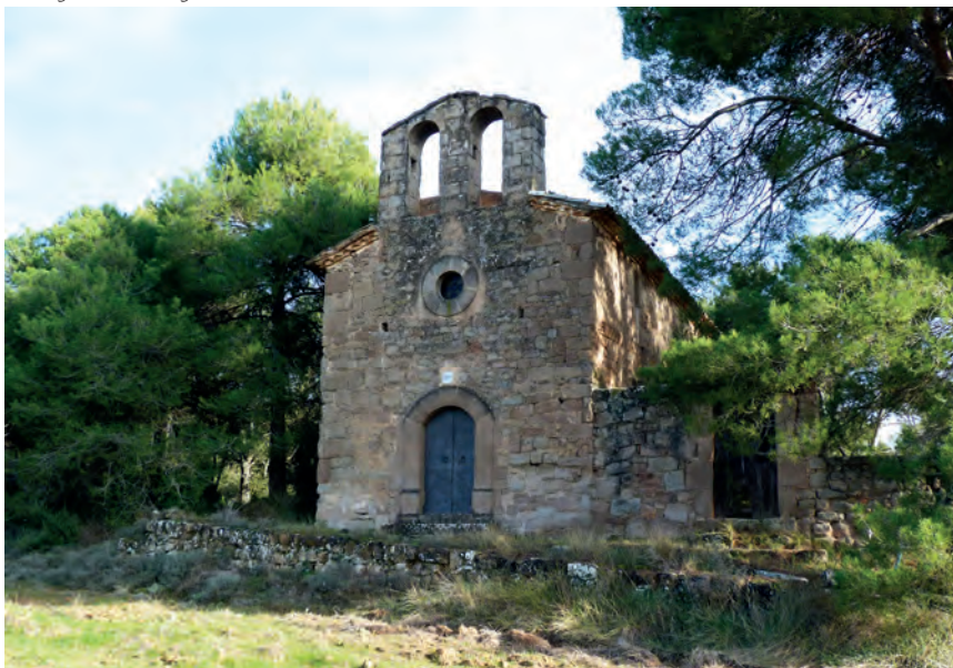
Vista general de la iglesia
