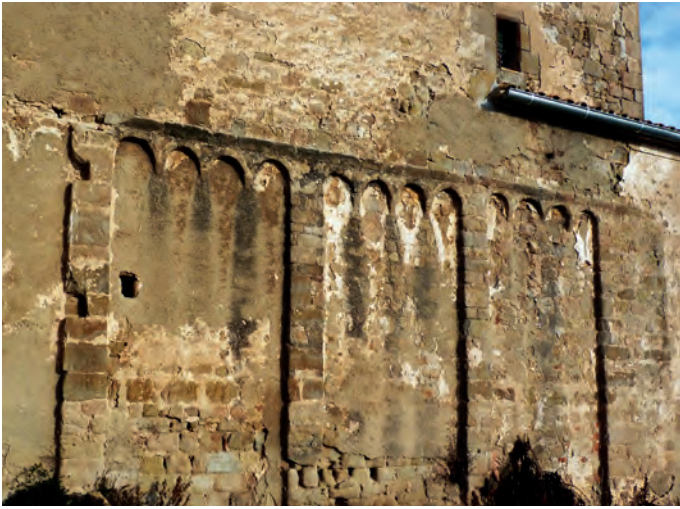
Vista del exterior del muro sur
