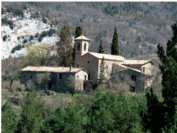
Vista general del conjunto
