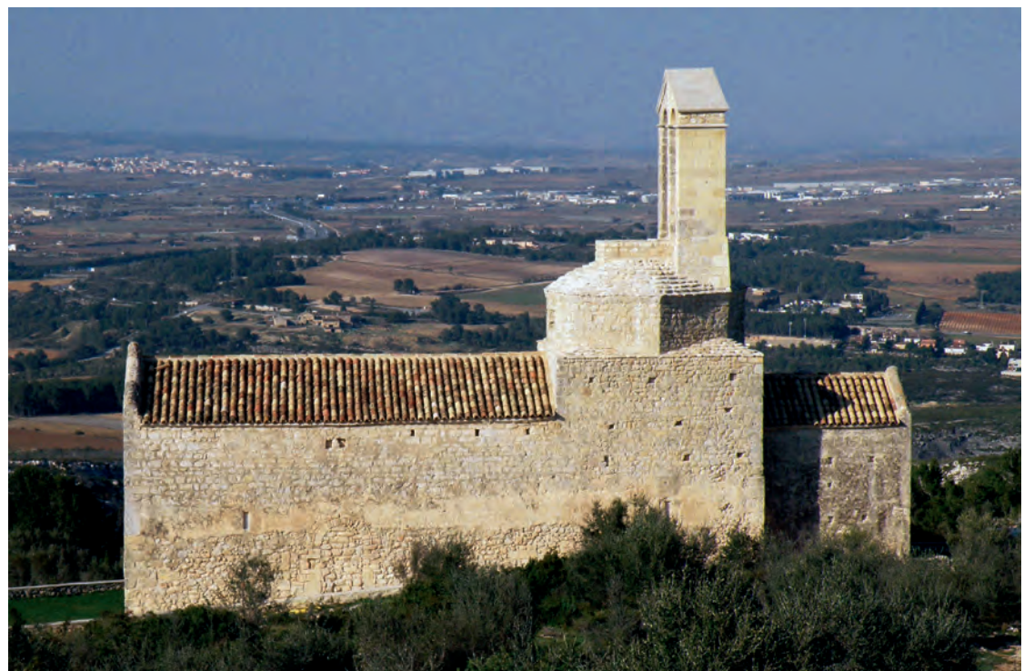
Vista general de la fachada meridional
