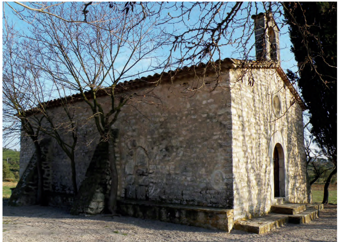
Vista general de la fachada septentrional
