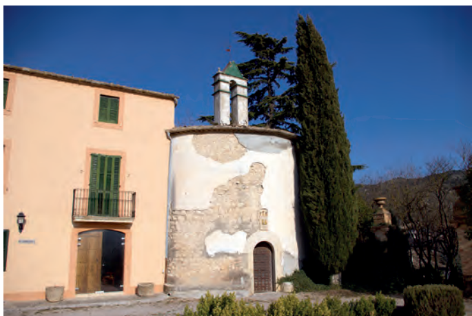
Vista general de la capilla
