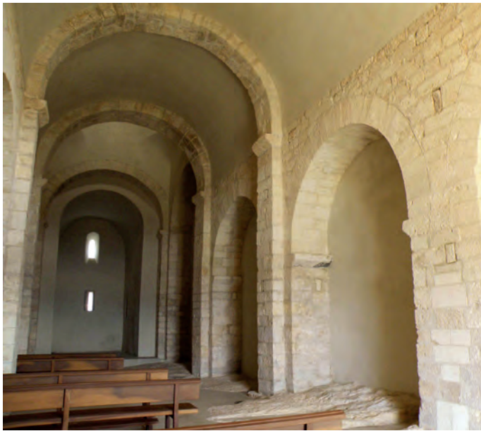
Interior de la nave hacia la cabecera
