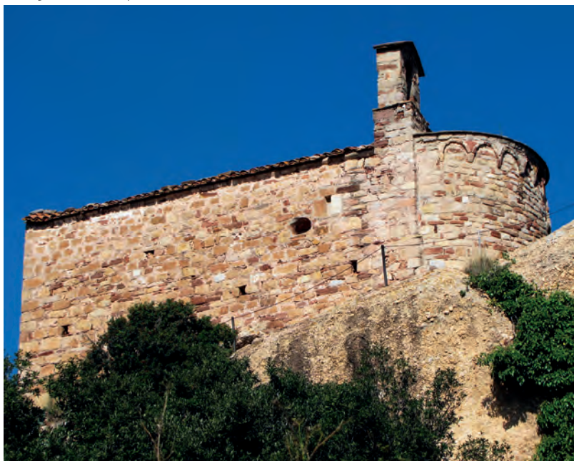
Vista general de la capilla
