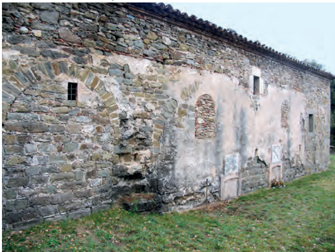
Muro sur con restos del antiguo atrio
