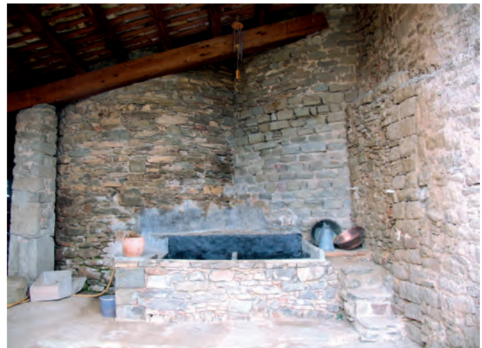
Base de la torre
