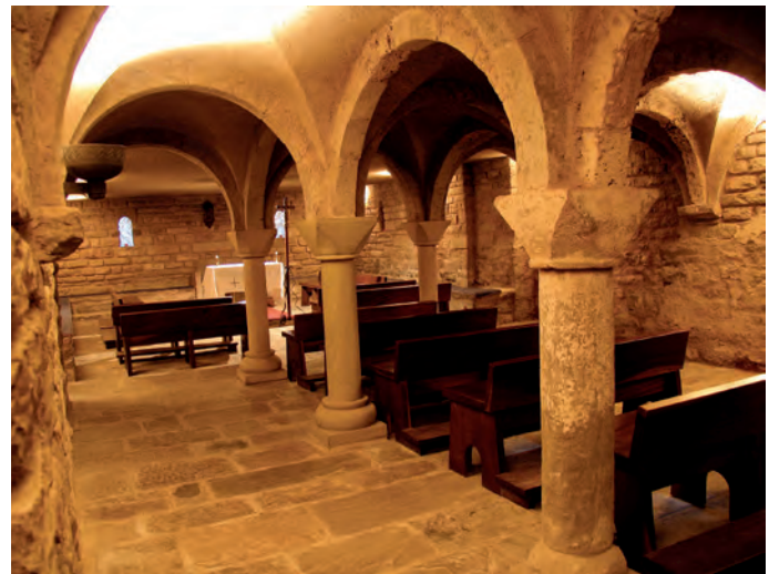
Reconstrucción de la zona de columnas
