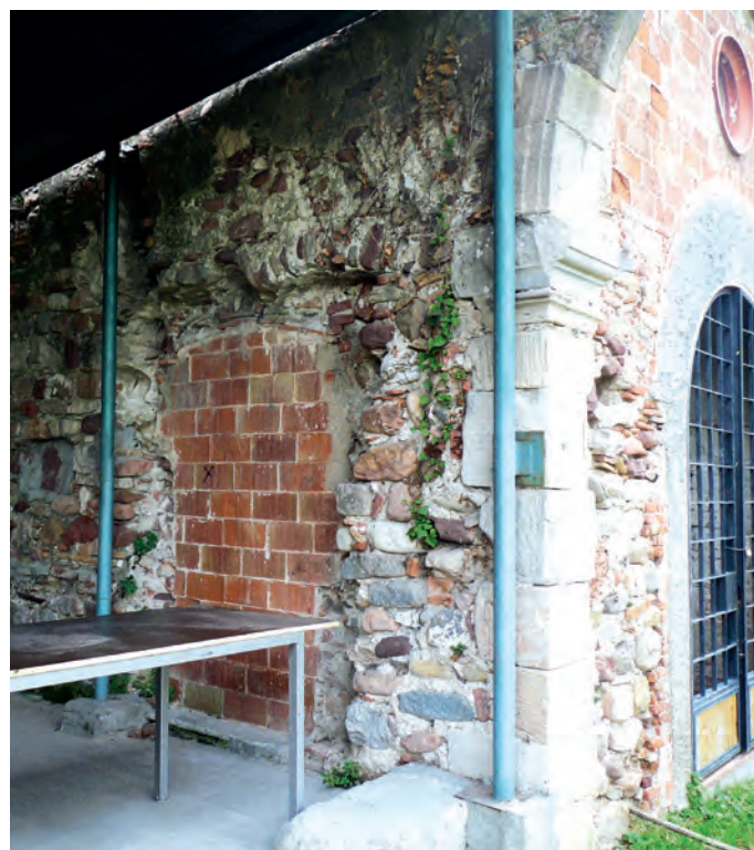
Posibles restos del sector meridional del ábside
