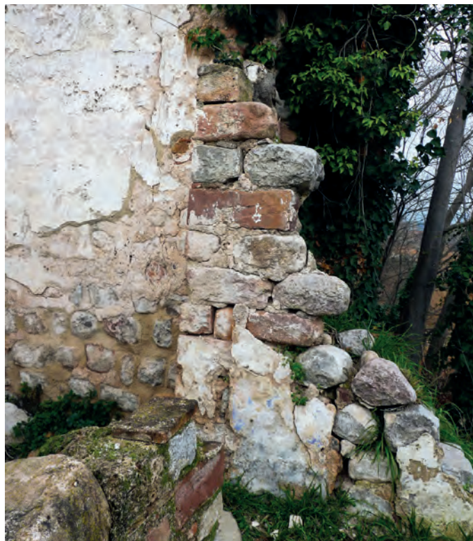
Restos de la muralla
