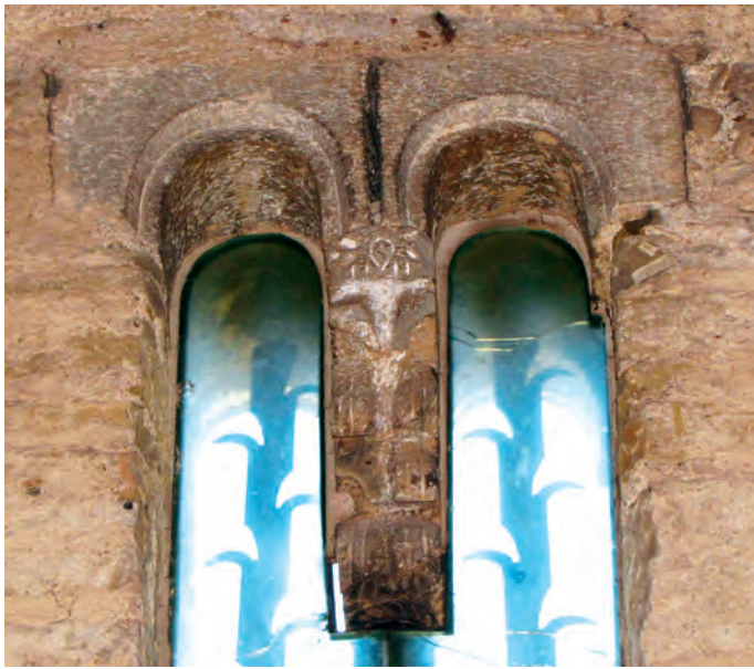
Interior de la ventana del muro occidental
