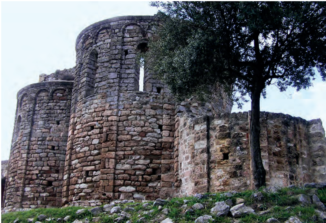
Ábsides de la iglesia de Santa Maria del Castell
