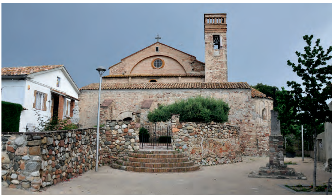
Vista general del actual edificio
