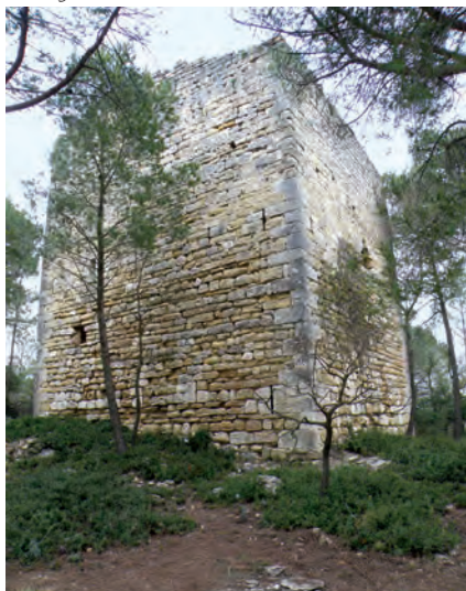
Vista general del torreón
