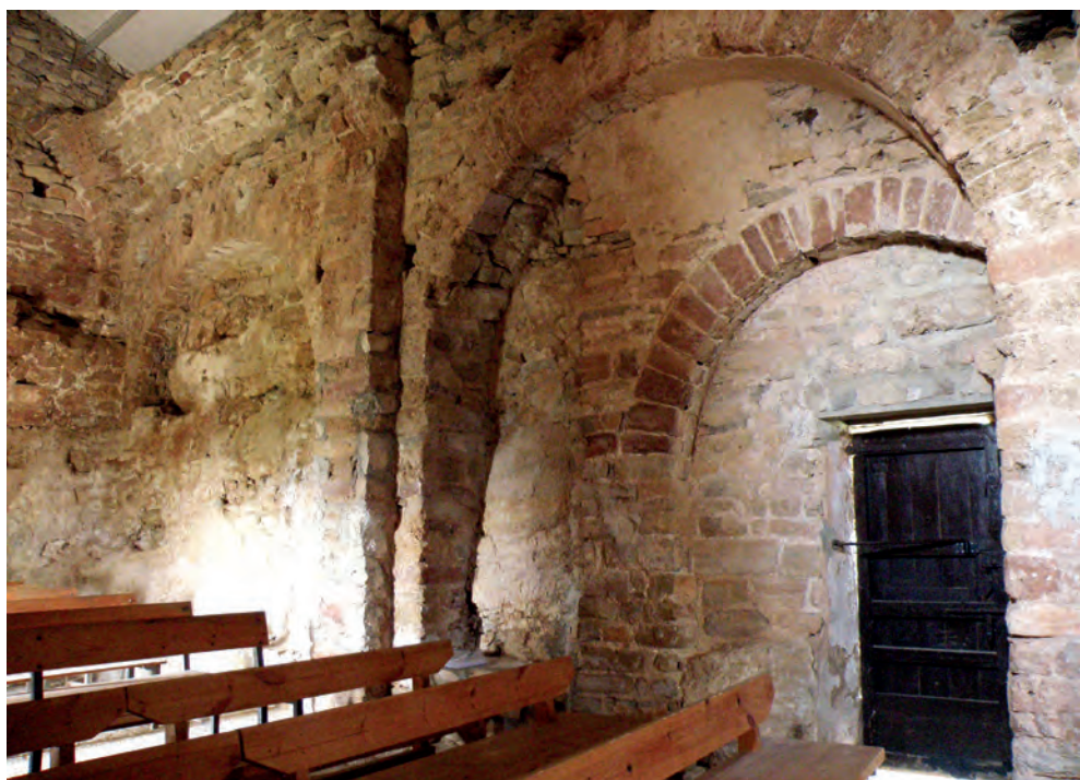
Arcos formeros del muro septentrional
