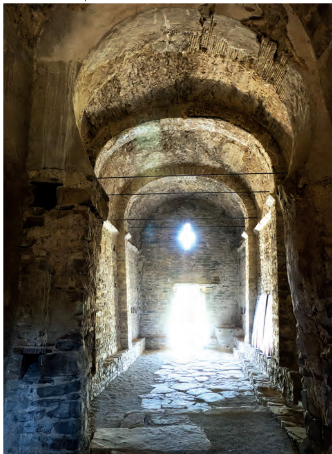
Vista interior del templo desde la cabecera
