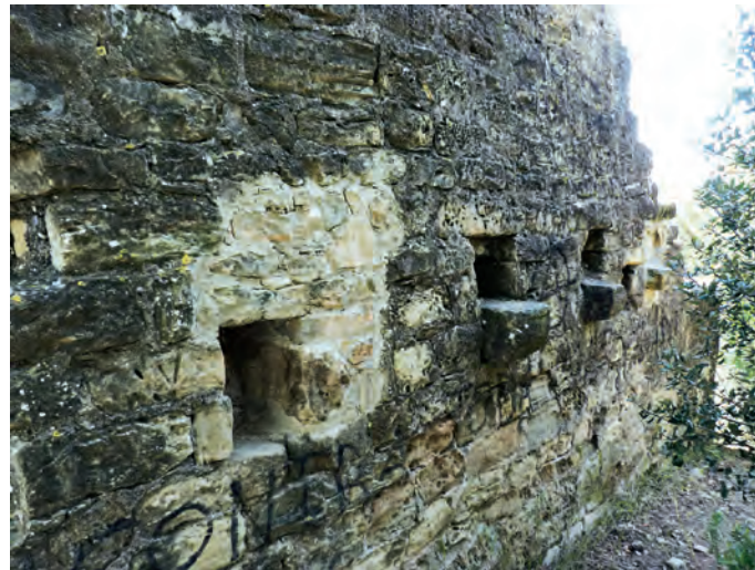
Ménsulas en el interior del muro sur del edificio
