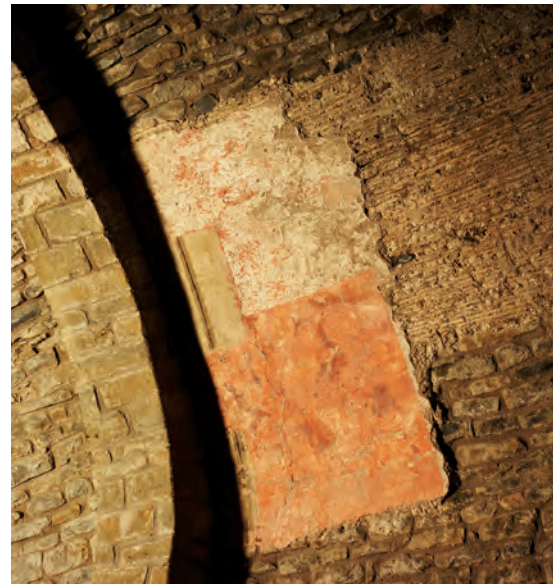
Restos de pinturas y de marcas de las cimbras en la bóveda
