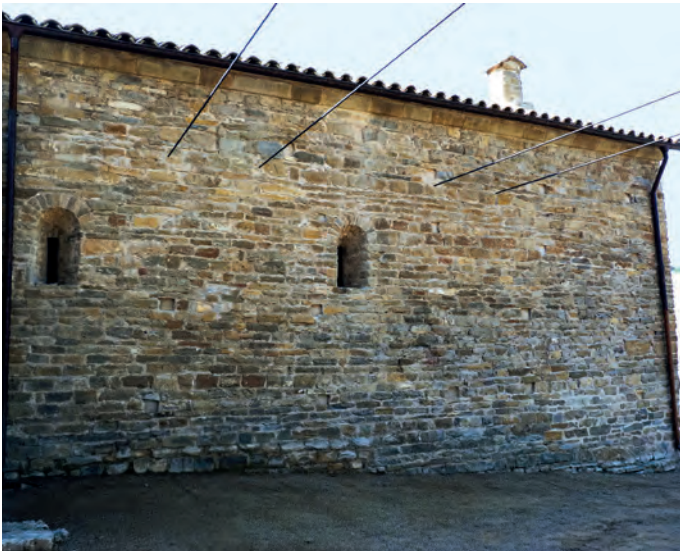
Vista exterior del muro norte de la nave
