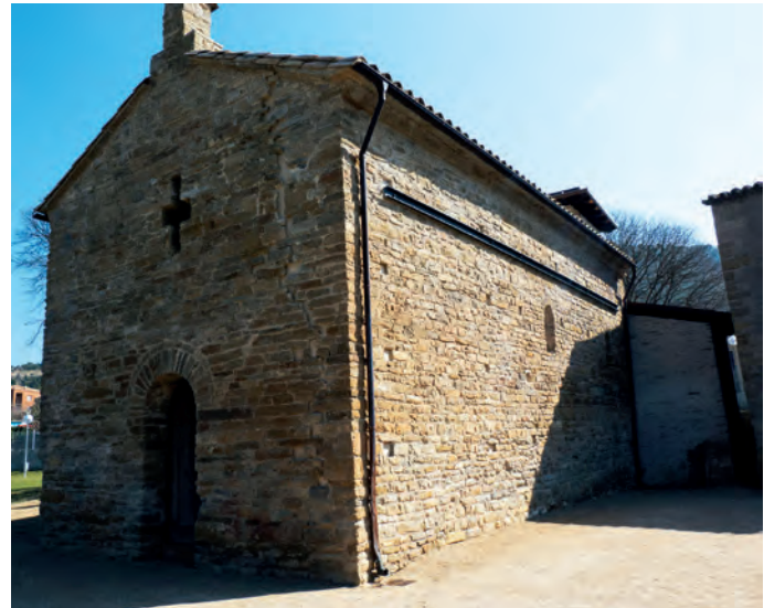
Vista general exterior desde el Suroeste
