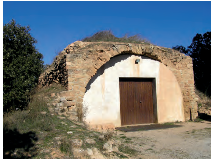
Estancia situada junto a la torre
