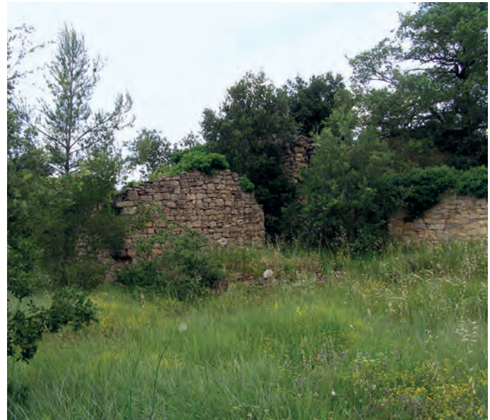
Detalle de uno de los muros
