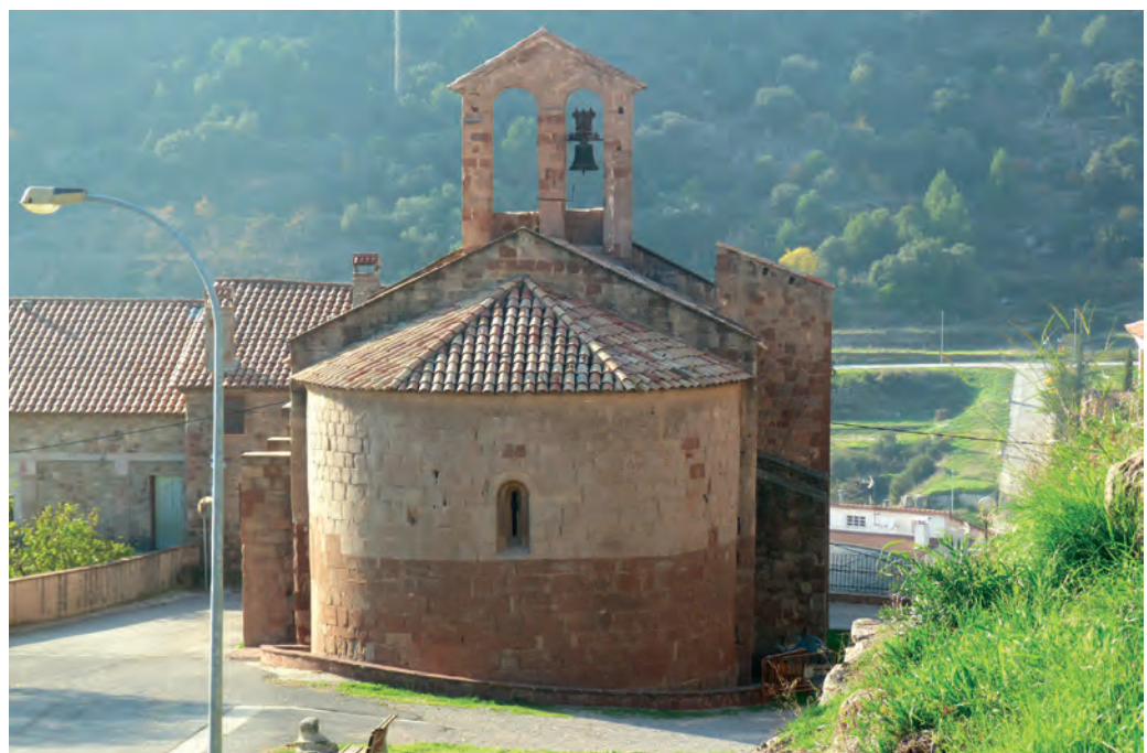
Vista general de la cabecera
