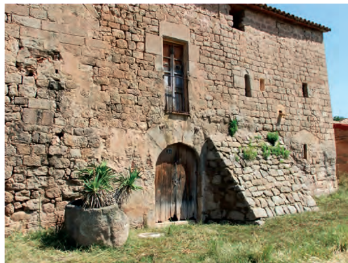
Fachada principal donde, a su derecha, se observan los muros medievales
