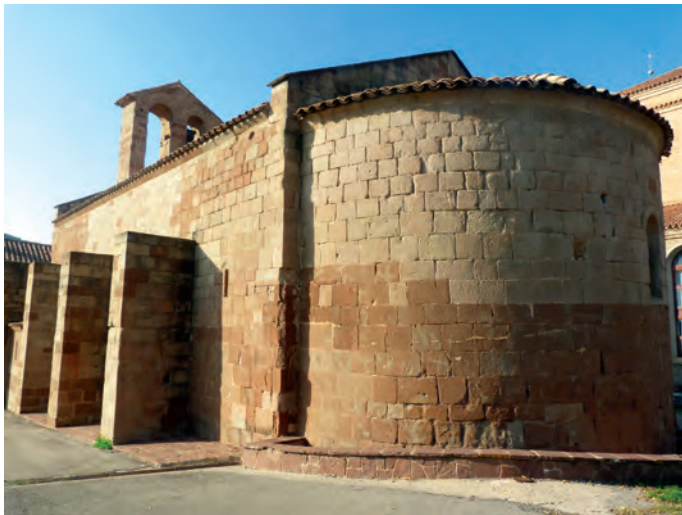
Ábside y muro sur
