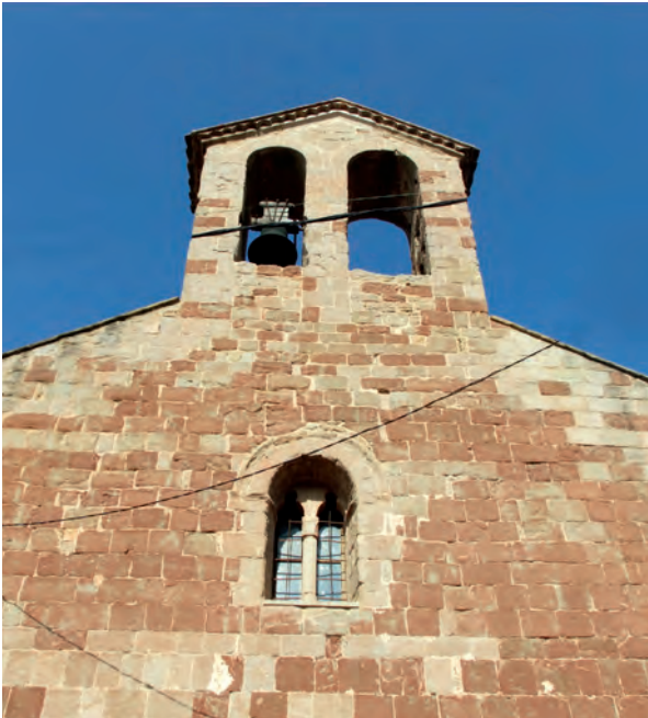
Fachada oeste, frontispicio y espadaña
