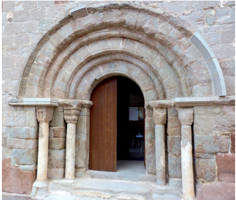
Fachada oeste, portada
