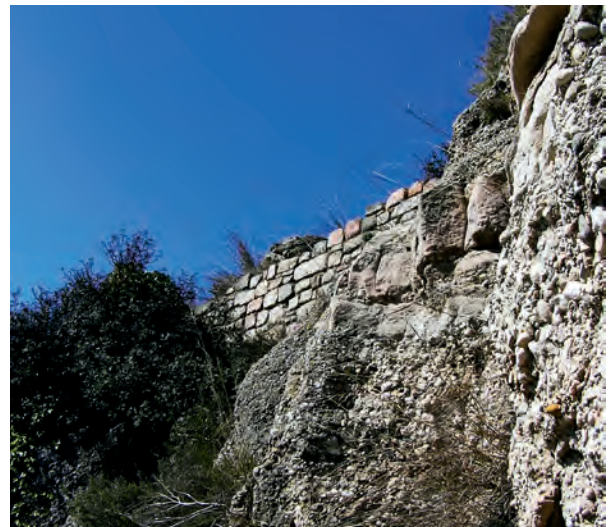
Detalle de uno de los muros
