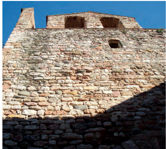
Detalle del muro oeste
