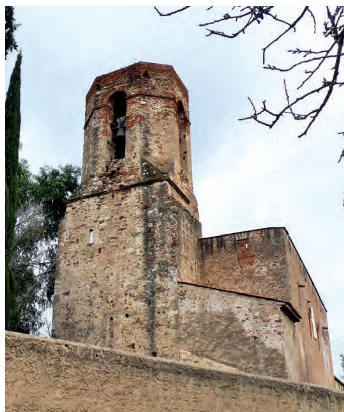
Vista general del actual edificio
