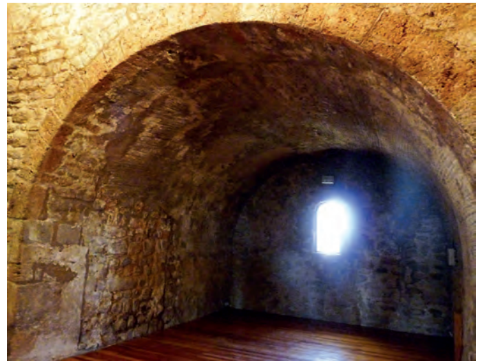
Interior del ábside
