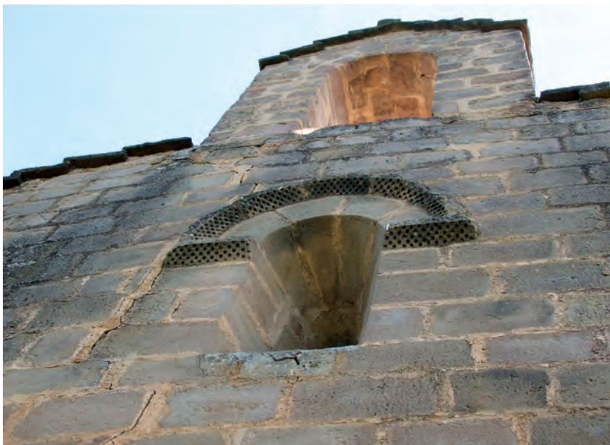
Ventana de la fachada oeste
