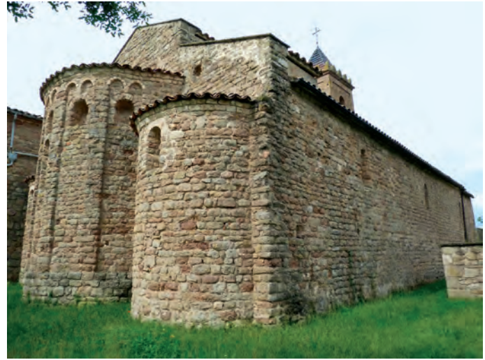
Detalle de la cabecera y fachada norte
