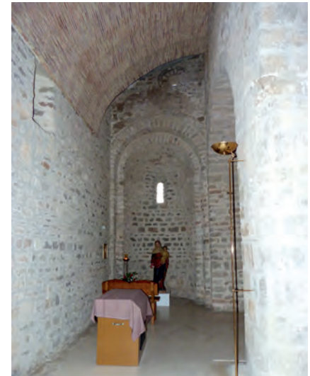
Nave del evangelio
