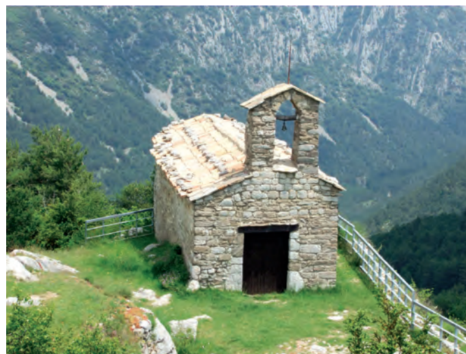
Vista general de la capilla
