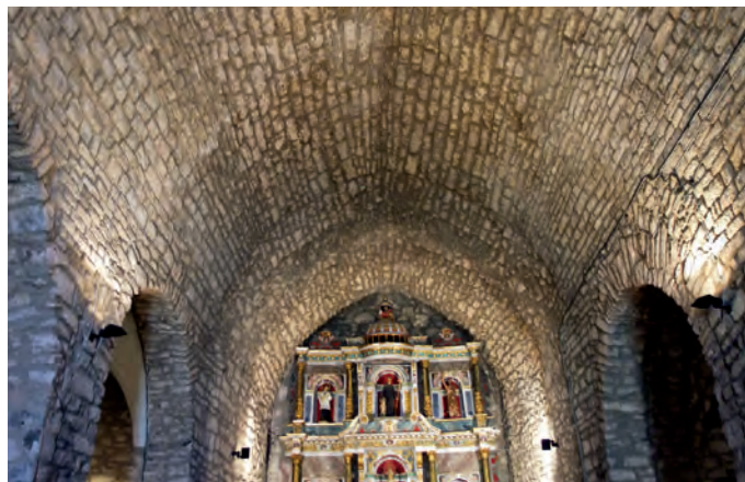
Bóveda de la nave central
