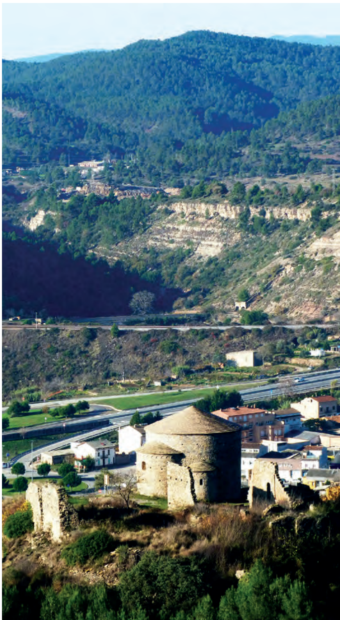
Vista general del conjunto
