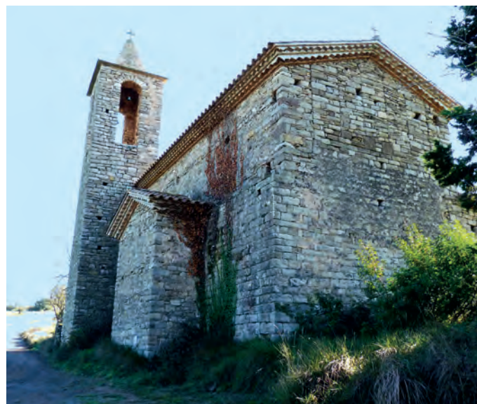
Vista exterior lado oeste
