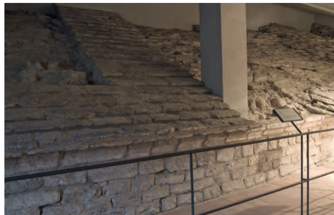
Parte superior de la nave de la iglesia del siglo XI, conservada por encima del nivel de la bóveda actual
