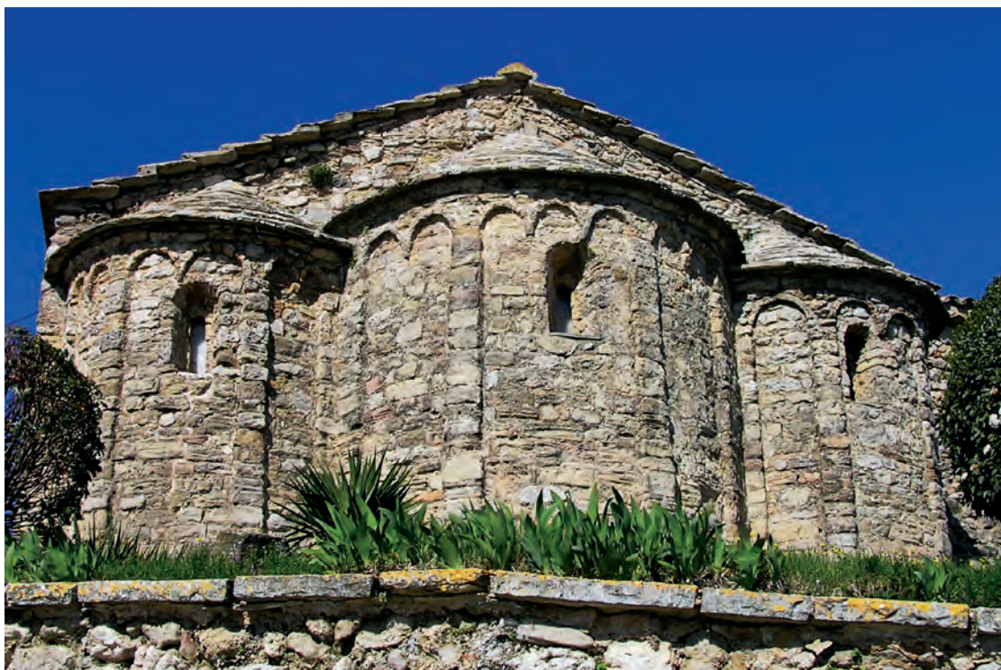
Detalle de los ábsides
