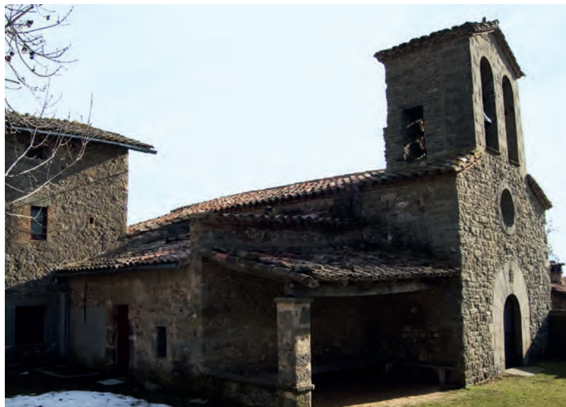
Vista general Absidiolo de la nave de la epístola
