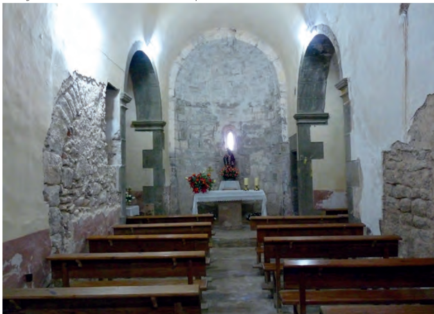
Vista general del interior con restos de un arco tapiado en el muro norte
