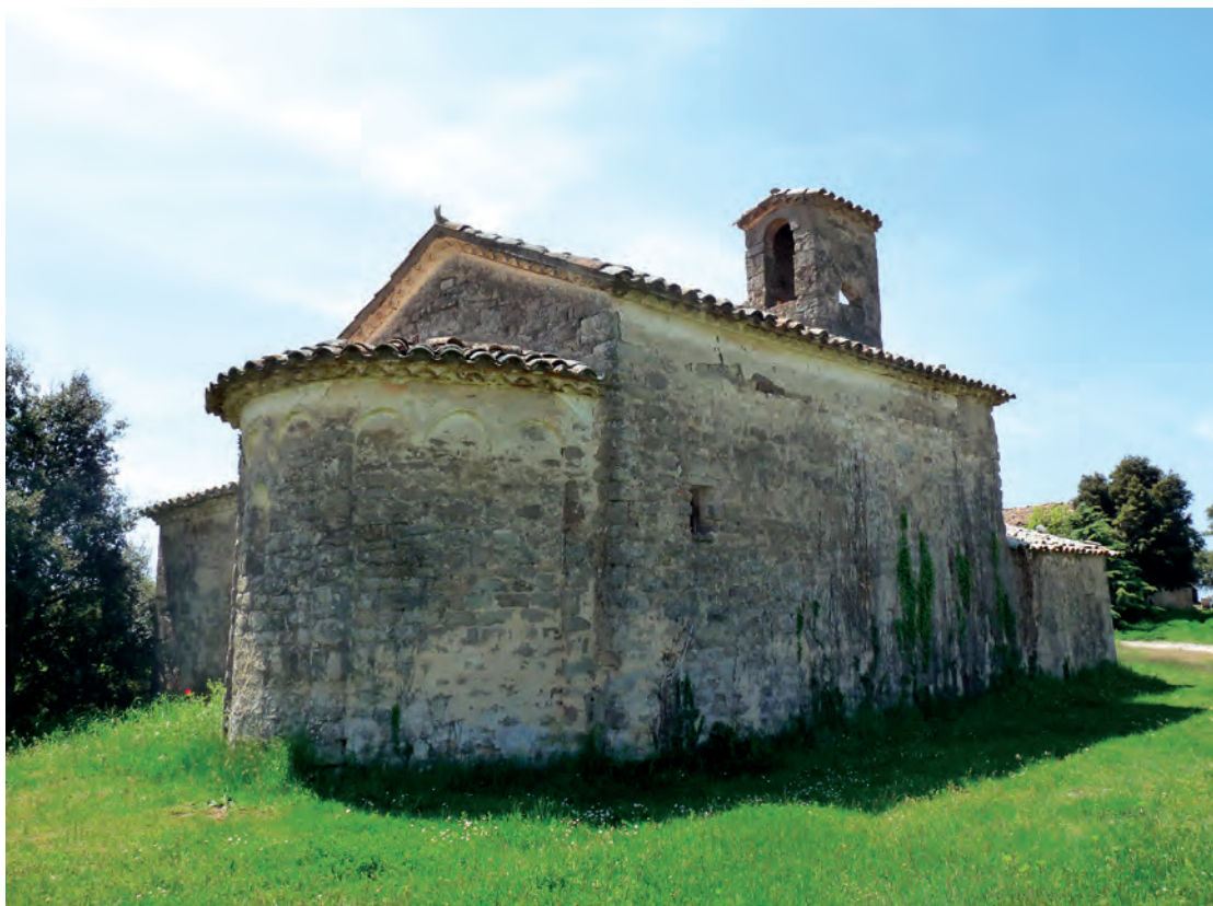
Vista general desde el lado nordeste
