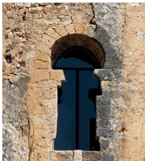
Puerta de acceso a la torre
