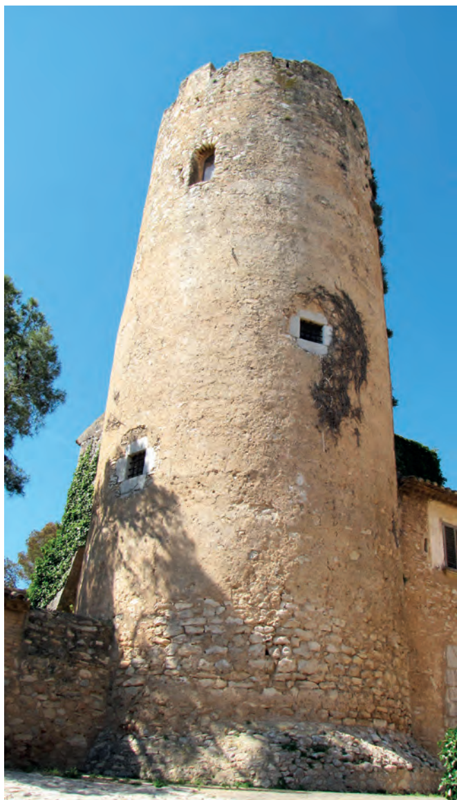
Vista general de la torre
