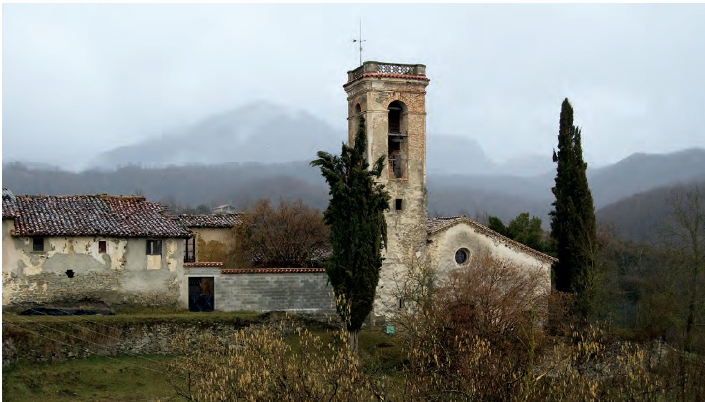
Vista general del actual edificio
