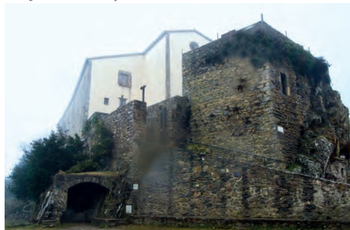
Vista general del actual edificio
