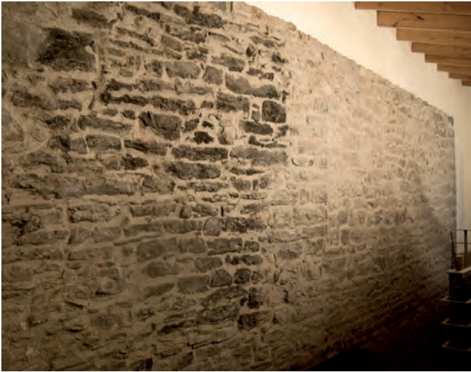
Exterior del muro lateral visible desde la hospedería
